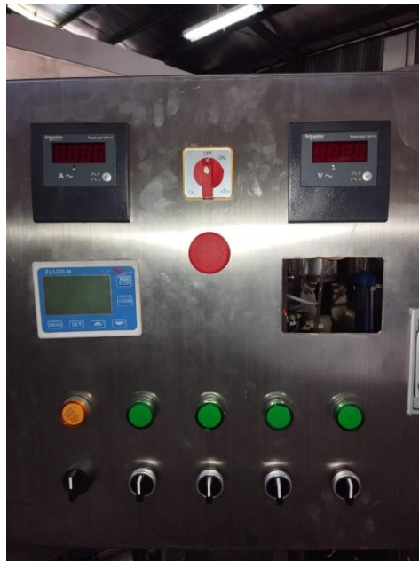
Gambar 4. Kontrol mesin IPAL manual
