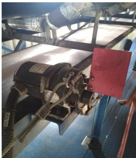
Gambar 7. *Pull cord switch* dalam kondisi trip
