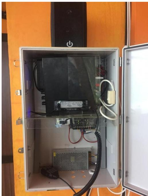
Gambar 12. Perangkat radio penerima (Rx) yang diinstalasi di Pos BPBD Anyer
