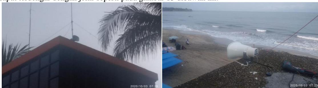
Gambar 13. Speaker Sistem Peringatan Dini Tsunami Terintegrasi yang dipasang pada atap gedung Pos BPBD Anyer
