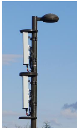
Gambar 2. 4 Antenna Microcell pada lampu jalan
