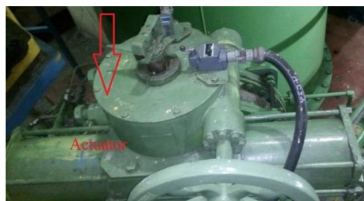
Gambar 11. Aktuator di PLTP UPJP Kamojang
